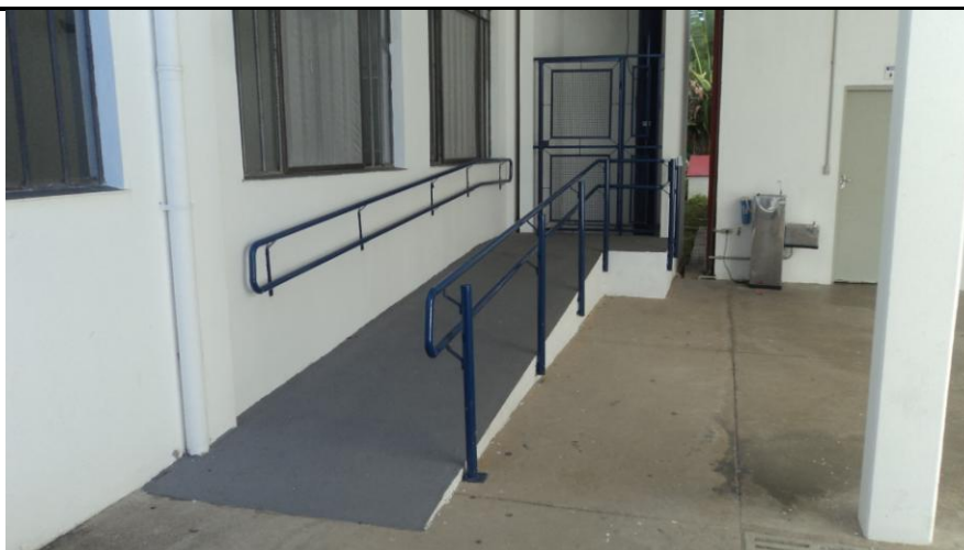
O elevador apresenta acessibilidade para PNEs.
