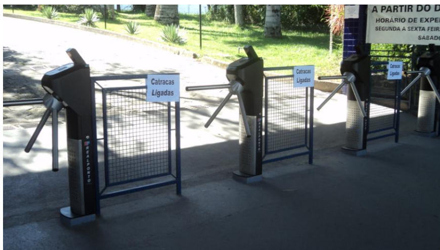
Catracas instaladas em entradas do campus
