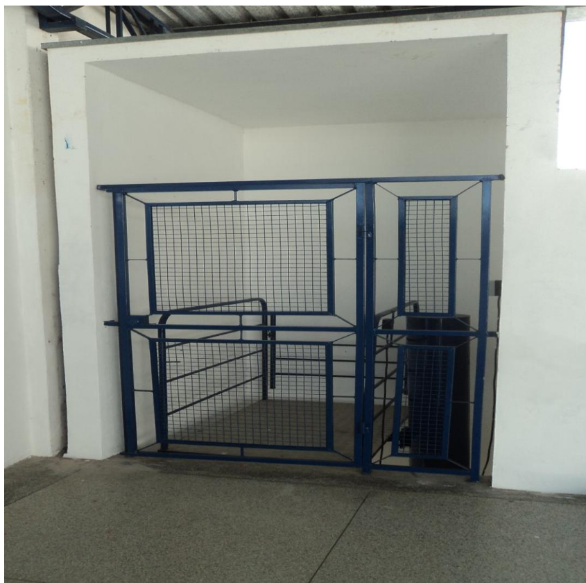
Elevador instalado do bloco J
