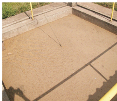
Tanque de Decantação
