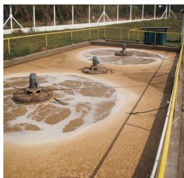
Tanque de Aeração
