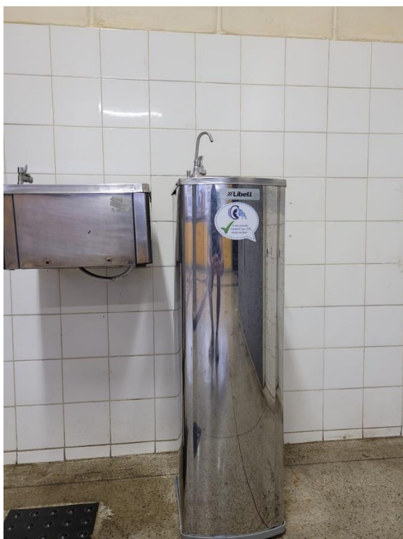
Substituição dos Bebedouros
