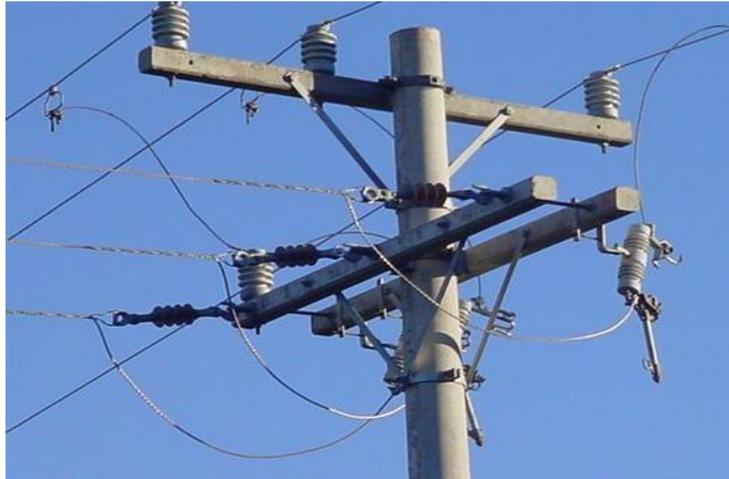
**Figura 1:** Poste com isolador, ferragem e cruzeta.
