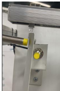
Figura 10 - Imagem da instalação do sensor NPN na estrutura do protótipo.
